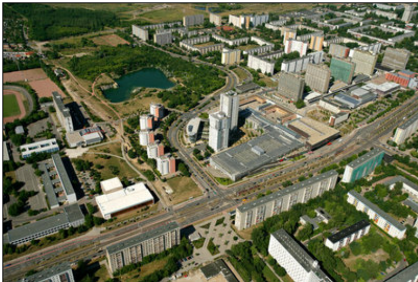
Das Luftbild von Neustadt zeigt den Sportkomplex (ganz links) sowie in der Mitte den Bruchsee und das Neustadt-Centrum mit dem Cinemaxx-Kino. (FOTO: GÜNTER BAUER)
