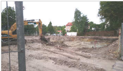
Ehemalige Baufirma Schopp (Hallesche Straße - Hier sollen 8 WE entstehen)
