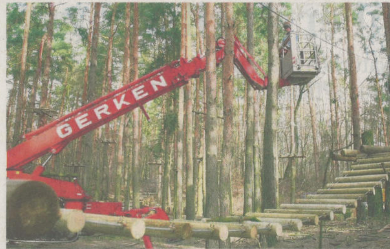
Am südlichen Rand der Heide wird ein Kletterwald gebaut.
