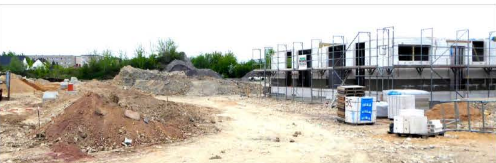
Die Bauarbeiten auf dem Gelände des ehemaligen Zementwerkes gehen weiter.
